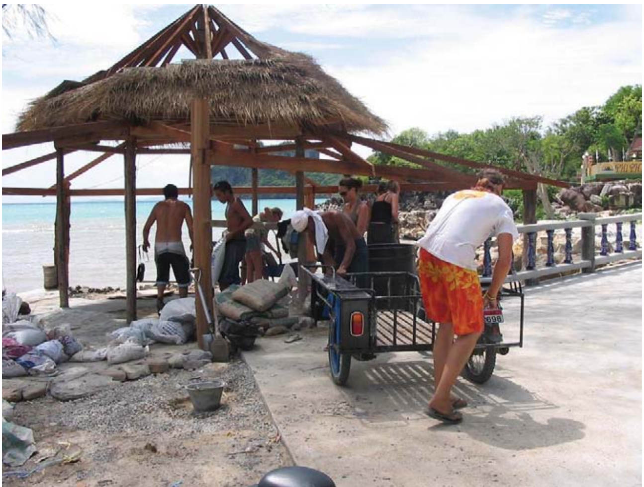
Freiwillige Helfer der „Hi Phi Phi“-Initiative beim Bau eines Aussichtspavillons an der Dalam Bay
